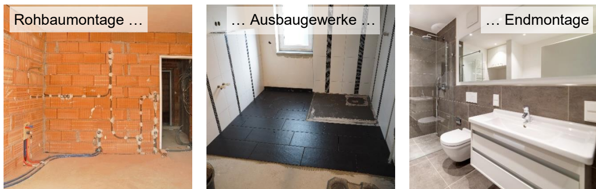
Bild 6 2-stufige Montage, gängige Baustellenpraxis bei anderen Gewerken (Quelle: links/Mitte/rechts: photo 5000/sonnee101/js-photo – stock.adobe.com)
