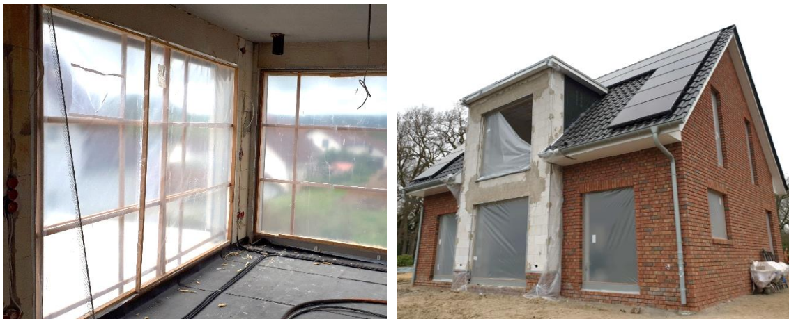
Bild 14 Vorab-Montagezargen z. B. für große, bodentiefe Hebe-Schiebe-Elemente (links) oder für unterschiedliche Einbausituationen (rechts) (Quelle: Finstral AG)
