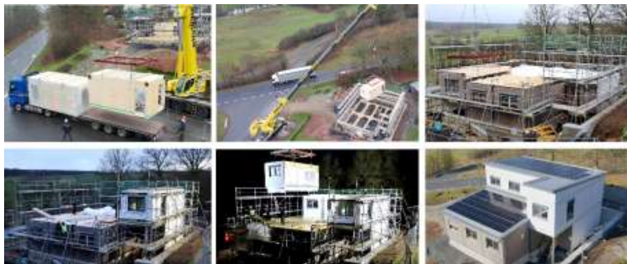
Montage eines Wohngebäudes mit „fast“ fertigen Raummodulen innerhalb weniger Tage (Bild: Oikos)
