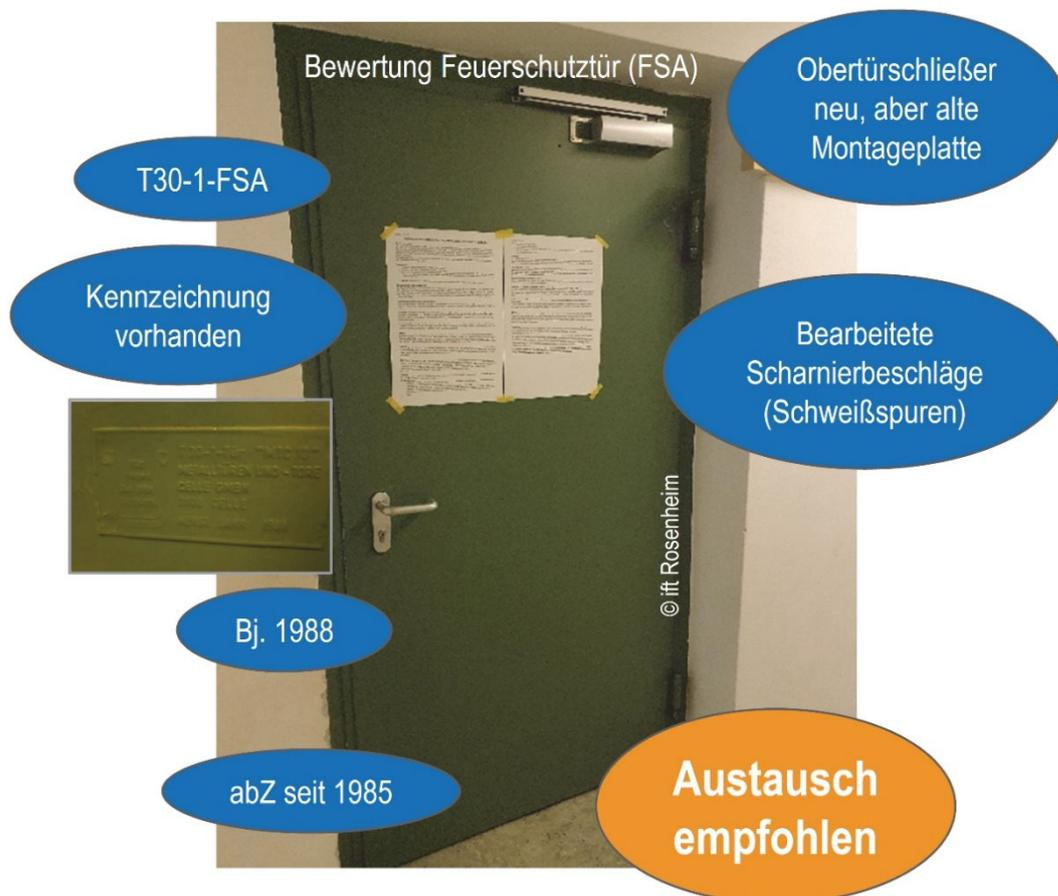
**Bild 2** Bewertung einer vorhandenen Feuerschutztür durch visuelle Beurteilung durch einen Sachverständigen (Quelle: ift Rosenheim)
