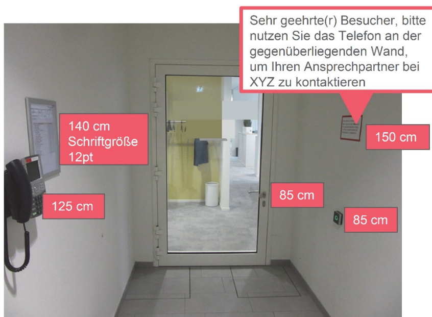
Bild 2 „Barrierefreie Tür“ – nicht barrierefrei
