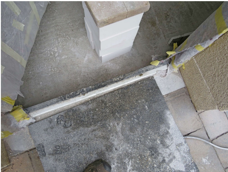
Bild 3 Raue Bedingungen auf der Baustelle
