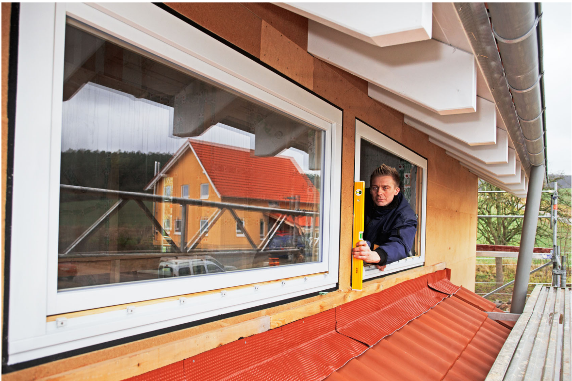
Bild 1 Eine fachgerechte Montage hat großen Einfluss auf die Funktion und Qualität von Fenstern und Türen (Bild Fotolia, Ingo Bartussek)
