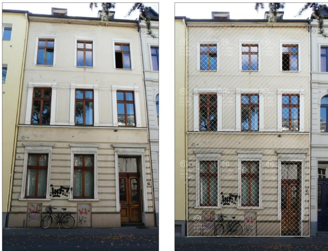
Bild 10 Mit modernen digitalen Aufmaß-Tools können Fotos von Fassaden optimal für die Angebotsphase genutzt werden. Eine fotogrammetrische Korrektur sorgt für die Kompensation der perspektivischen Verzerrung. (Bild: LLH Software GmbH, www.llh-software.de )
