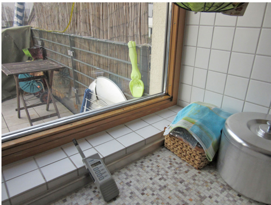
Bild 5 Ungünstige Positionierung des Fensters an der Arbeitsfläche entkoppelt von Warmluftströmungen im Raum
