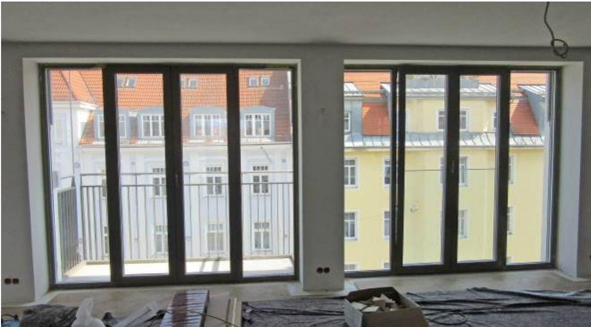
**Bild 11** Gleiche Fensterelemente, jedoch unterschiedliche Einbausituationen. Im (rechten Fall (ohne Balkon) hat das Element eine absturzsichernde Funktion und muss einschließlich der Befestigung zum Baukörper statisch nachgewiesen werden.
