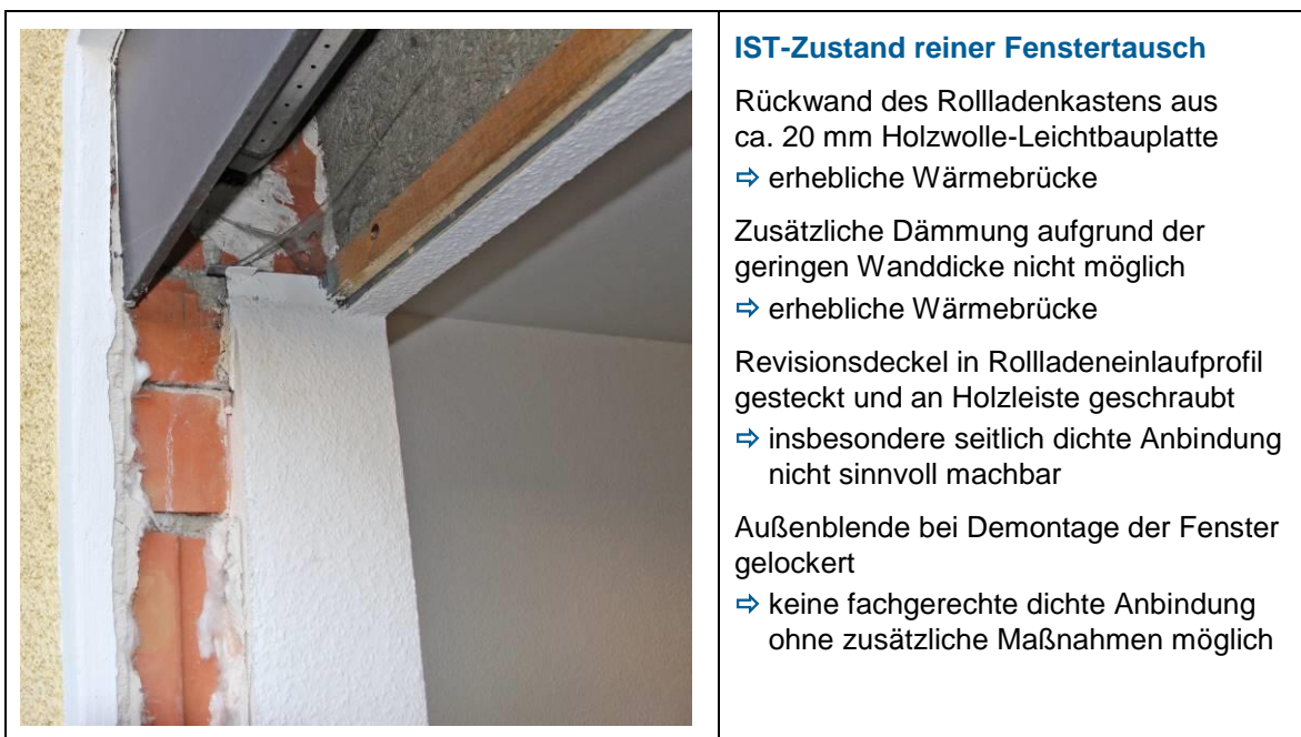
Bild 2 Beispiel zu Muster 1 (IST-Zustand reiner Fenstertausch)
