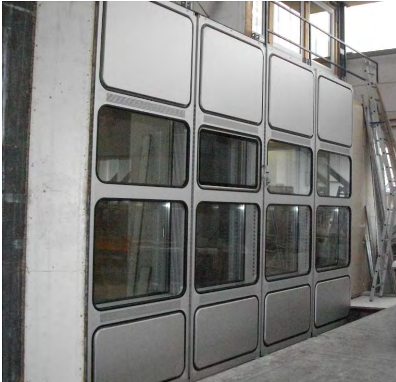
Bild A 14 Beispiel für eine Elementfassade im Großformat (Bildquelle: ift-Vorgang 12-001744)
