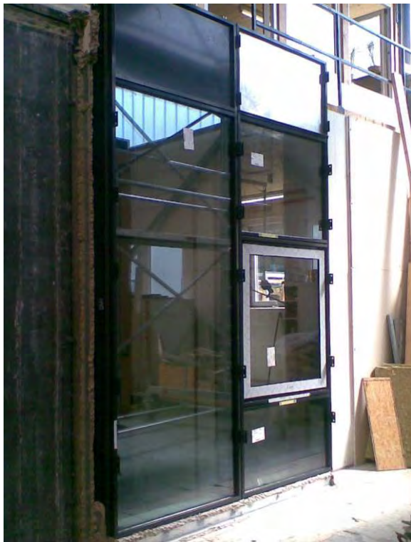
Bild A 12 Beispiel für eine Elementfassade im Großformat (Bildquelle: ift-Vorgang 11-001961)
