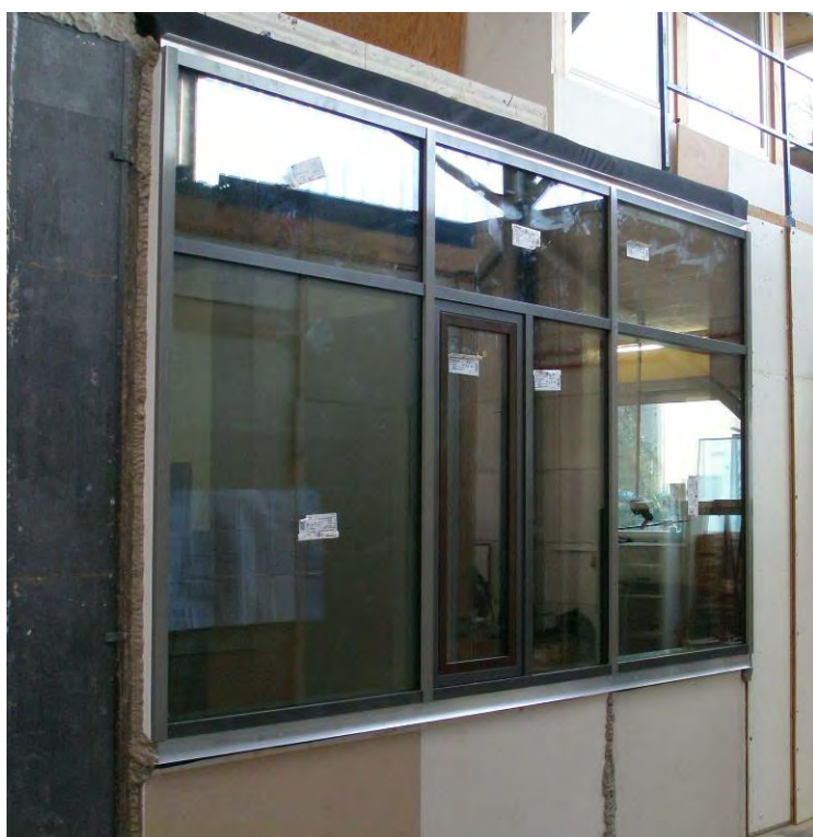
Bild A 10 Beispiel für eine Pfosten-Riegel-Fassade mit Einsetzelement im Großformat, (Bildquelle: ift Vorgang 169 41537)
