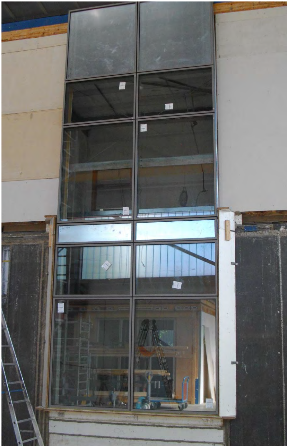
Bild A 95 Ansicht der geprüften Elementfassade (Aufbau 1)
