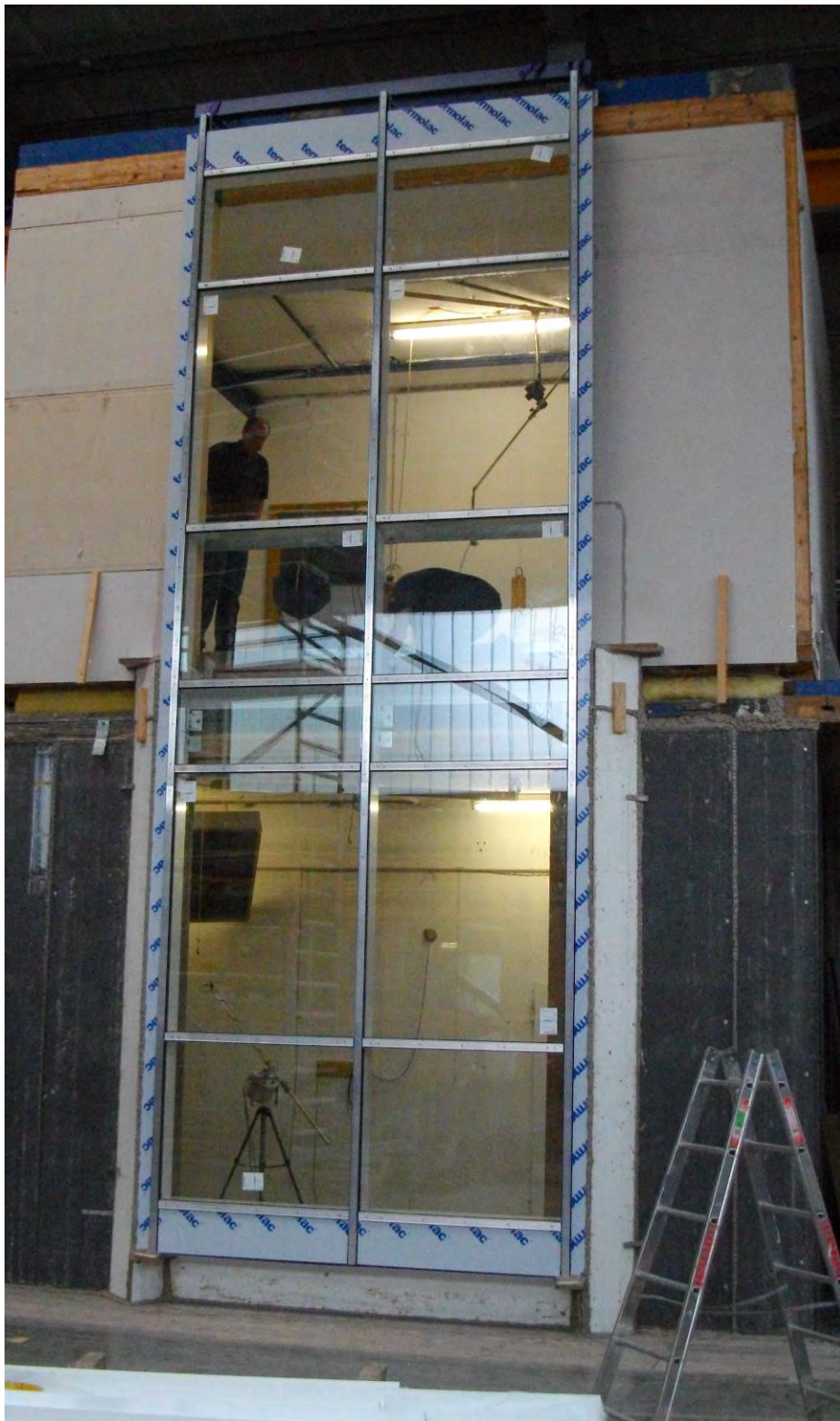
Bild A 70 Ansicht der geprüften Fassade
