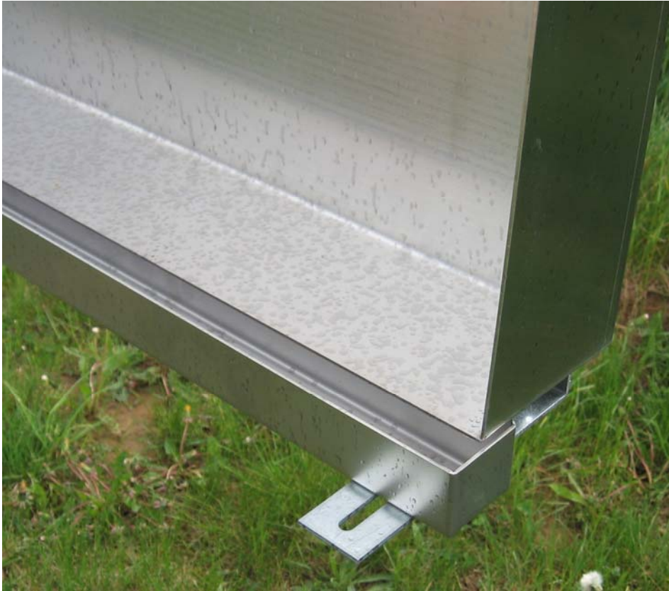
Abbildung 5-6 Detail Halteschale mit Sammelrinne
