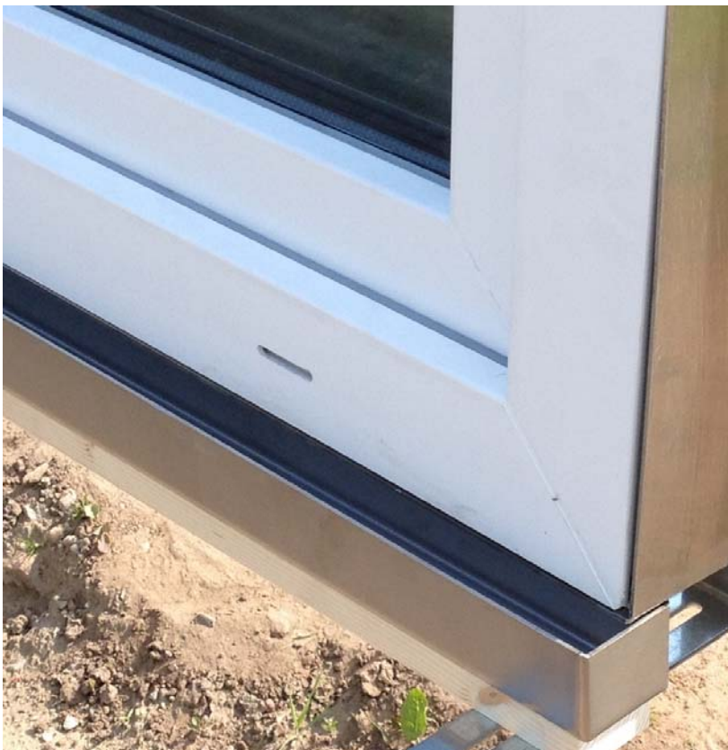
Abbildung 5-7 Detail in Halteschale montiertes Fenster und Sammelrinne
