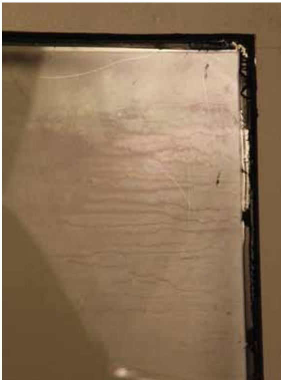
Abbildung 7 Gealterter Probekörper mit korrodierter low-e-Beschichtung und unzureichendem Butylauftrag auf den Kanten oben und rechts sowie in der Ecke, Hersteller 13
