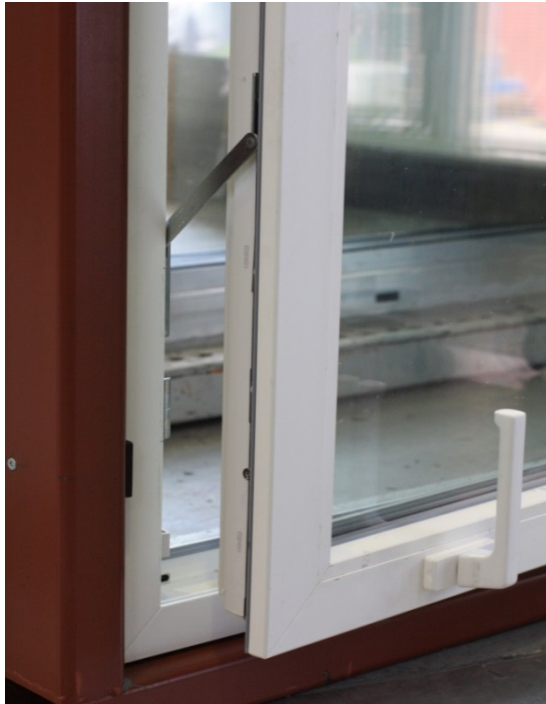
Abbildung 3 Beispiel für einen Zusatzbeschlag. Einflügeliges Drehfenster mit Lüftungsfangschere und leicht erreichbaren Griff am unteren Flügelrahmenprofil
