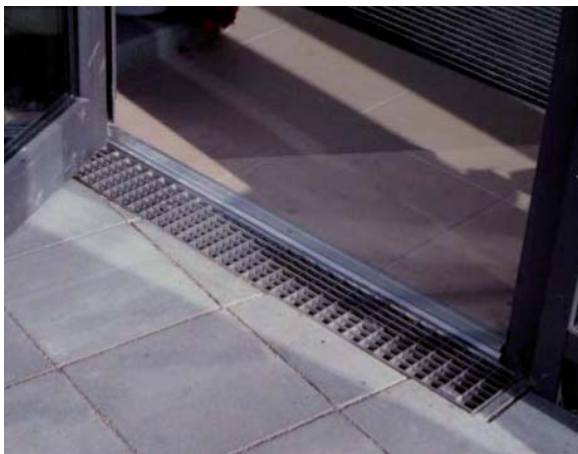
Bild 4 Schwellenfreier Zugang mit Wassersammelrinne und Gitterrost
