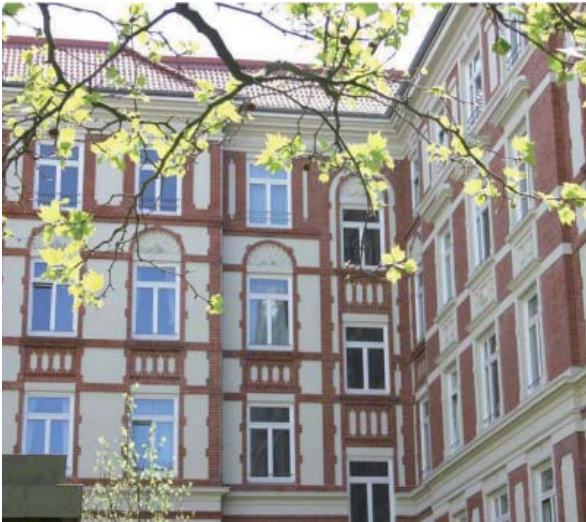
Bild 3 Bei der Fenstermodernisierung sollte auch der gestalterische Aspekt berücksichtigt werden. Fotoquelle: © Menck Fenster GmbH, Hamburg
