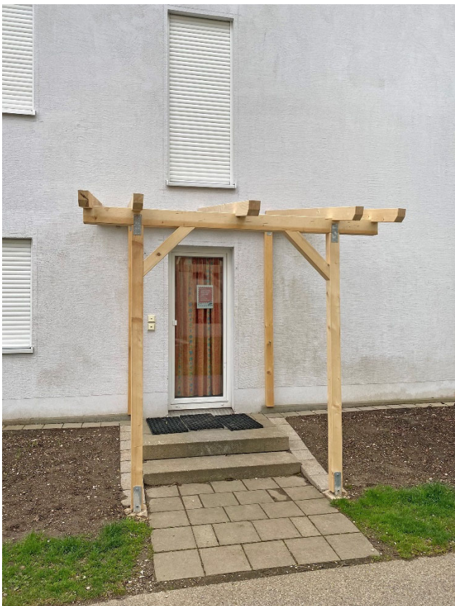
Bild 1 Nachrüstung einer westlich orientierten Nebeneingangstür mit Vordach
