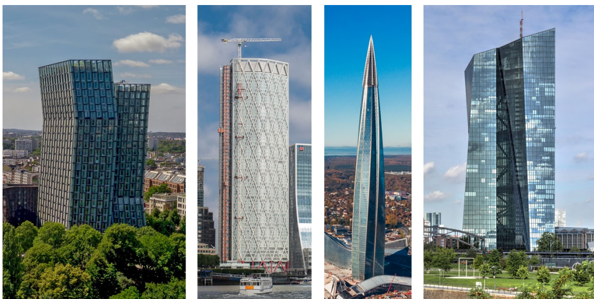
Bild 1 Hochhäuser mit Glasfassaden weltweit unter Beteiligung des ift Rosenheim (Quellen: © Jonas Weinitschke, GioRez, Parilov, Frank_Wagner, alle stock.adobe.com)
