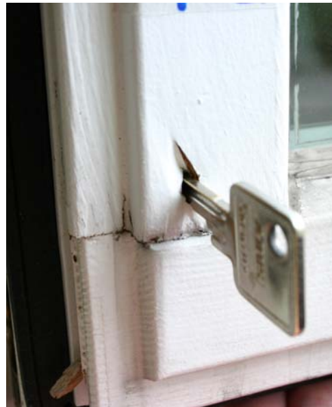
Bild 3 Fäulnis an Pfosten-Riegel-Verbindung (links) und in der Rahmeneckverbindung (rechts)
