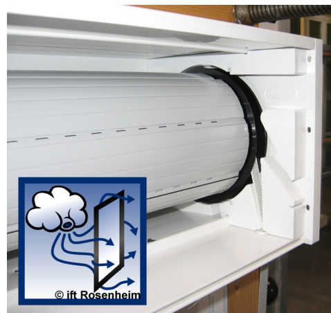
Bild 1 Luftdichtheit von Rollladenkästen
