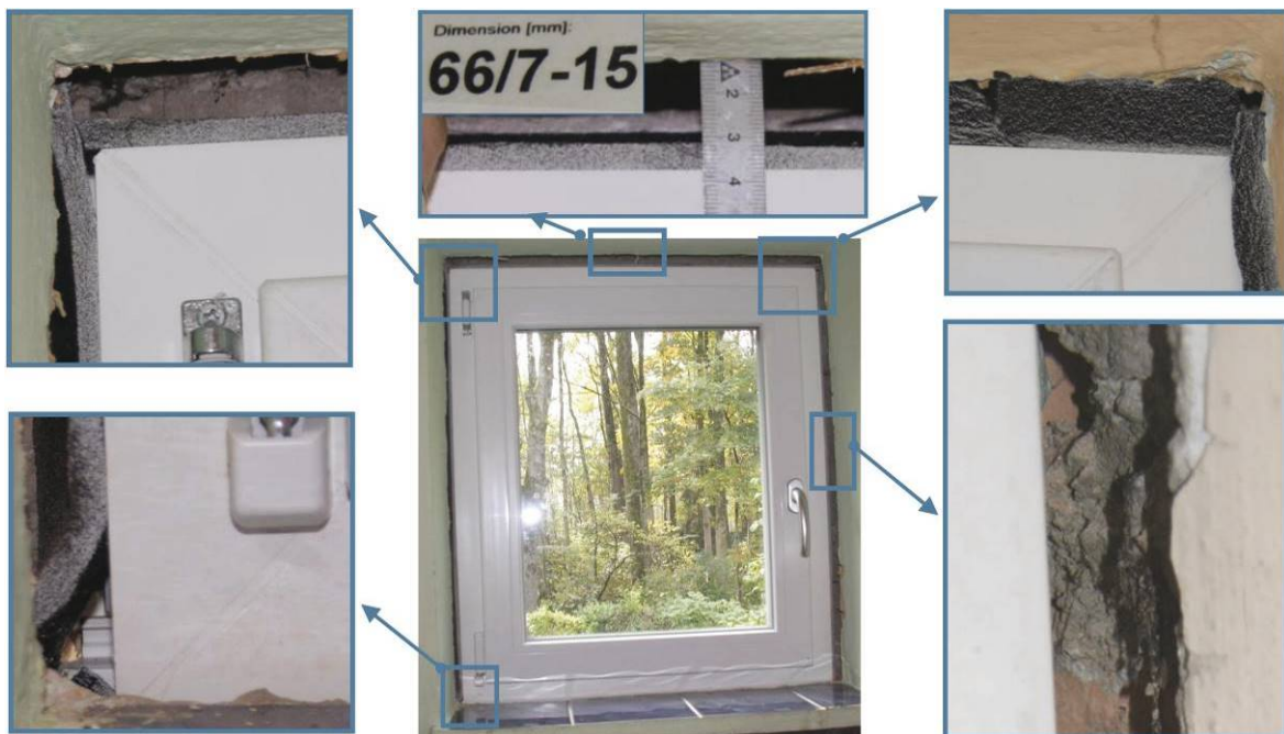
Bild 1 Typische Fehler aus der täglichen Praxis der ift-Gutachter am Beispiel von Fugendichtbändern
