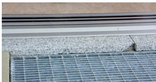
Schwelle durch Absenkung des Entwässerungsgitters
