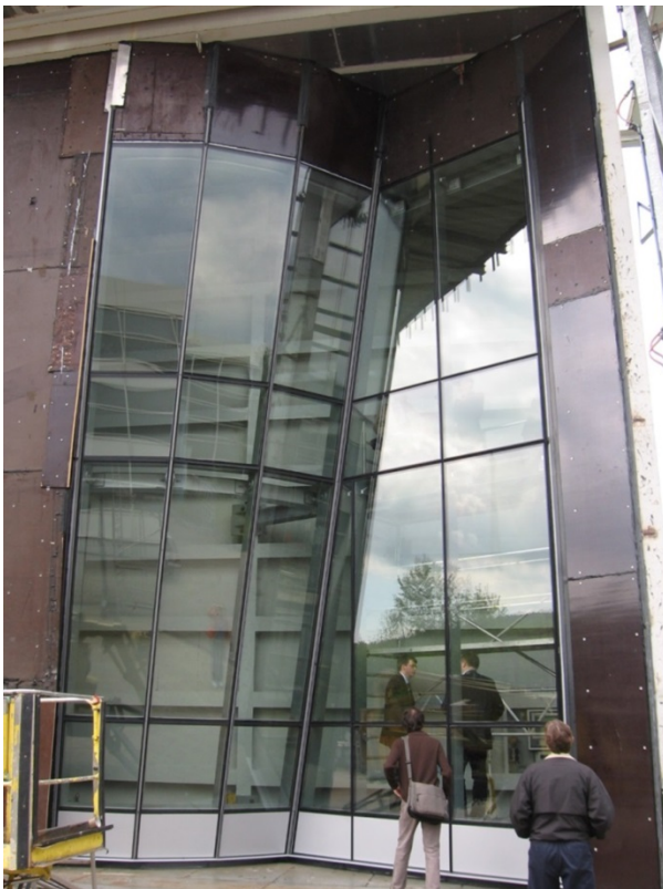
Bild 1 Objektprüfungen ausgefallener Fassaden im ift Rosenheim bringen Sicherheit für Planer, Bauherr und Hersteller (Rockefeller University (NY), Schüco, Frener & Reifer Brixen)
