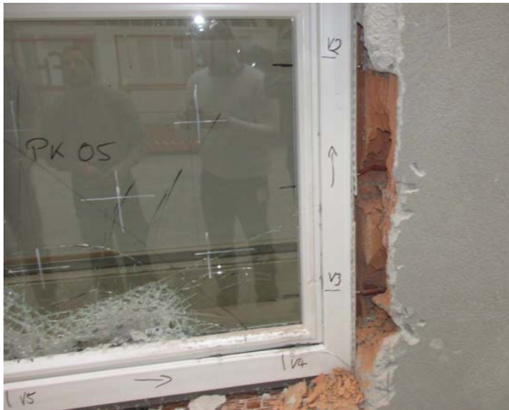
Bild 1 Fenster nach mehreren manuellen Angriffen in RC2.
