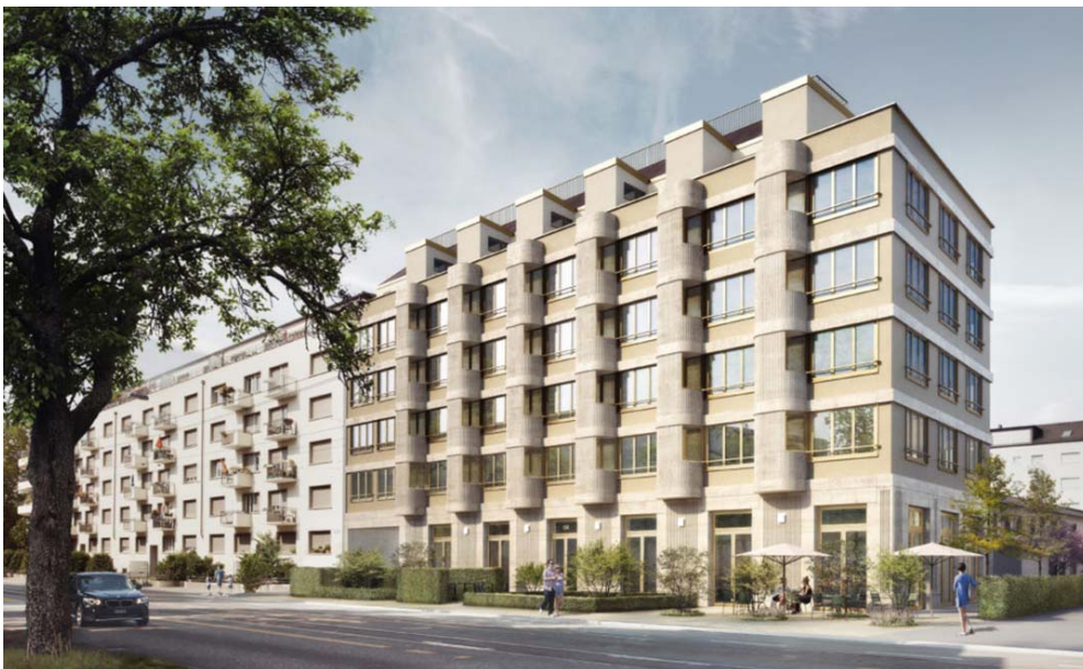
Bild 2 Bauvorhaben aus dem Jahr 2017 in der Hohlstraße in Zürich mit Vakuum-Isolierglasscheiben (Quelle: Schwarz Architekten/GlassX)
