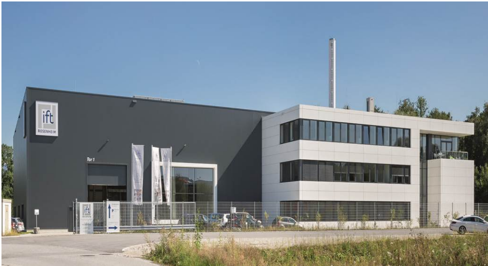
Bild 5 Das ift Technologiezentrum ermöglicht schnelle und effiziente Brandprüfungen von großformatigen Bauteilen bis zu 8 m x 5 m für national und international notwendige Nachweise nach EN, UL und weiteren Standards.
