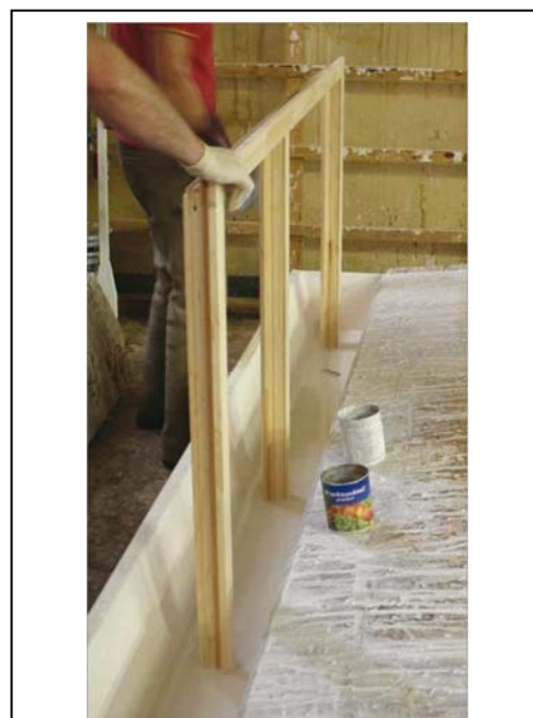
Bild 1 Holzschutzbehandlung eines fertigen Rahmens durch Tauchen
