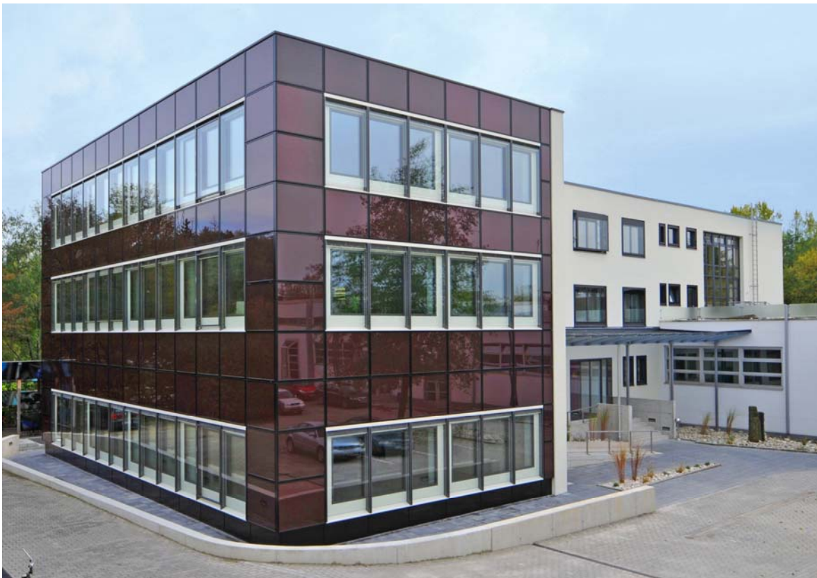
Bild 6 Fassade am ift Rosenheim als BIPV in Dünnschicht-Technologie
