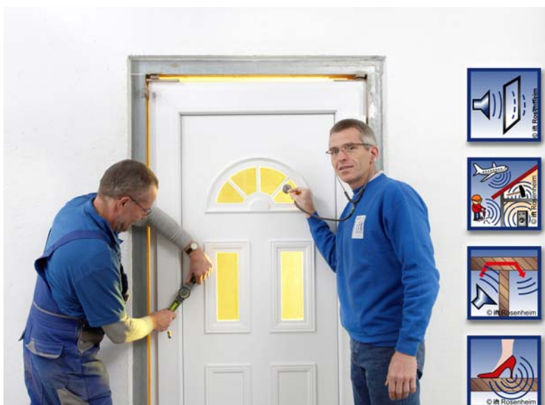
Bild 1 Der Schallschutz von Bauelementen wird auf Herz und Nieren geprüft
