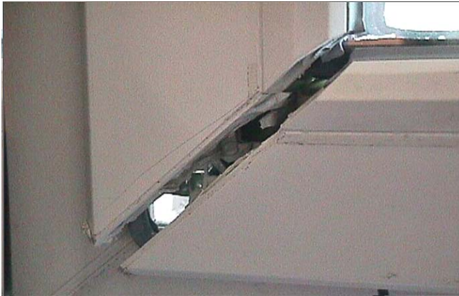
Bild 2 gebrochene Rahmenecke
