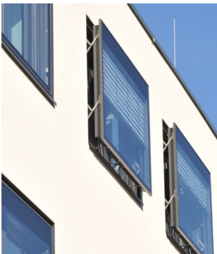
Bild 1 Moderne Verbundfenster mit automatisch offenbarem Lüftungsflügel und Integrierter Verschattung beim sanierten Bürogebäude des ift Rosenheim
