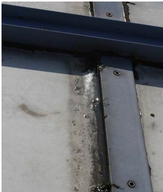
Bild 3 Beispiel von Wasser- und Schmutzansammlungen trotz geringer Bauhöhe der Presseleiste am Riegel ift Fachinfo VE-12/1 [4])
