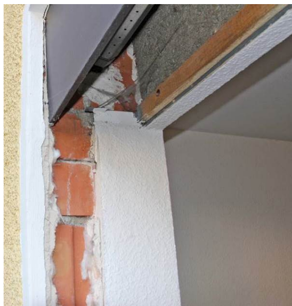
Bild 2 Beispiel Fehlertyp 1 (IST Zustand reiner Fenstertausch)
