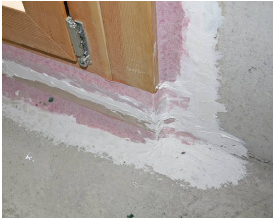
Bild 4 Beispiel Fehlertyp 2 (IST-Zustand Baukörperabdichtung)
