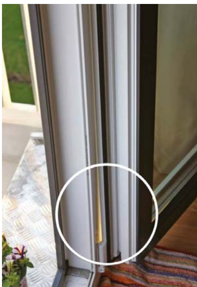
Bild 2 Verdrehtes, schwarz beschichtetes Kunststoff-Fenster mit ungleichmäßigem Lichtspalt
