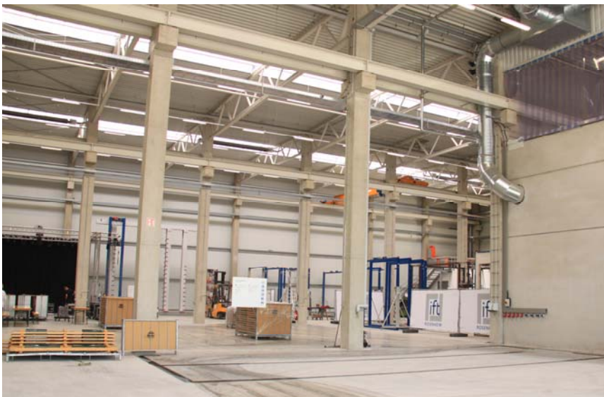
Bild 5 Blick in die großzügige Prüfhalle
